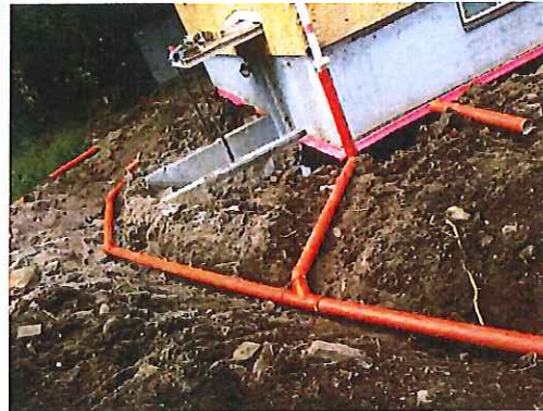
Bild 4. Dagvattenledningarna från stuprören till kassetten i gräsmattan
