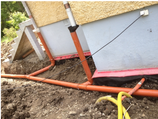
Bild 4. Dagvattenledningarna från stuprören till kassetten i gräsmattan
