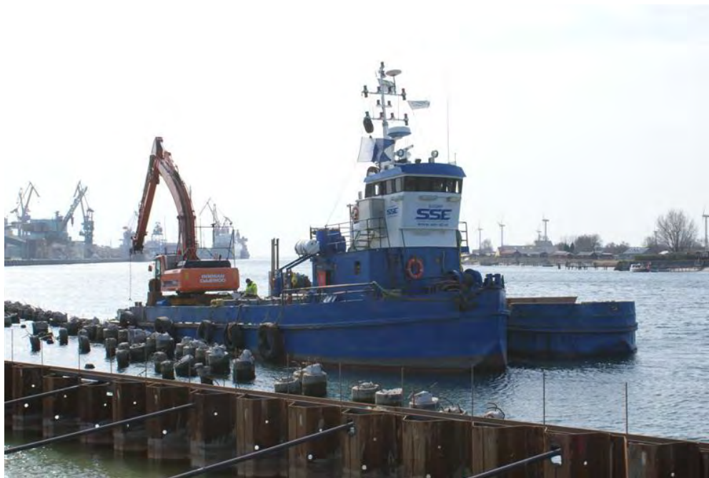
Figur 12, Arbetspråm för tyngre anläggningsarbeten från vatten.
