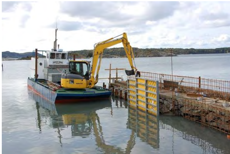
Figur 11, Mindre enskopeverk utför pirarbete.
