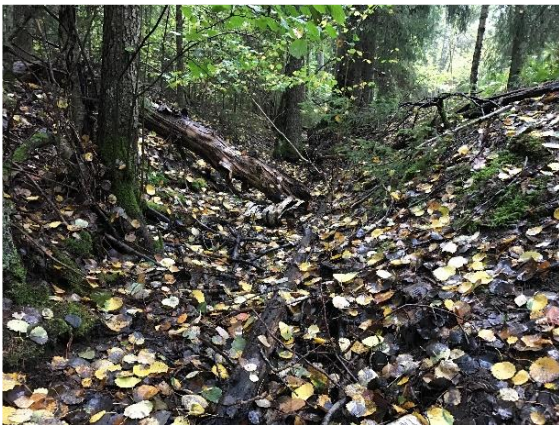
Figur 15. Dike som avvattnar blandsumpskog, objekt 83 i Tattby naturreservat. Här skulle man kunna lägga igen diket en sträcka alternativt anlägga ett dämme/plugg.
