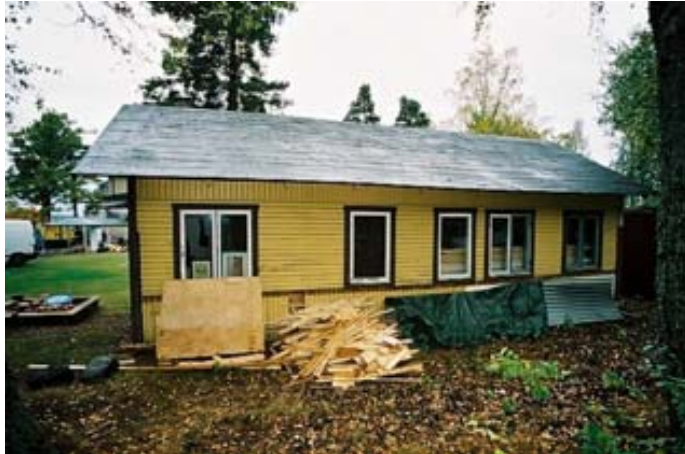
Hus 3 Bostadshus f.d. tvättstuga från söder. Senare fönster med enkla luffer.
