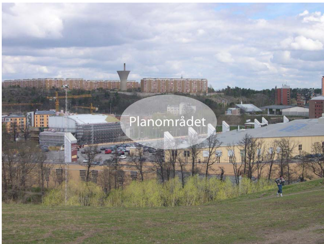
Området runt Nackarondellen sett från Hammarbybacken.
