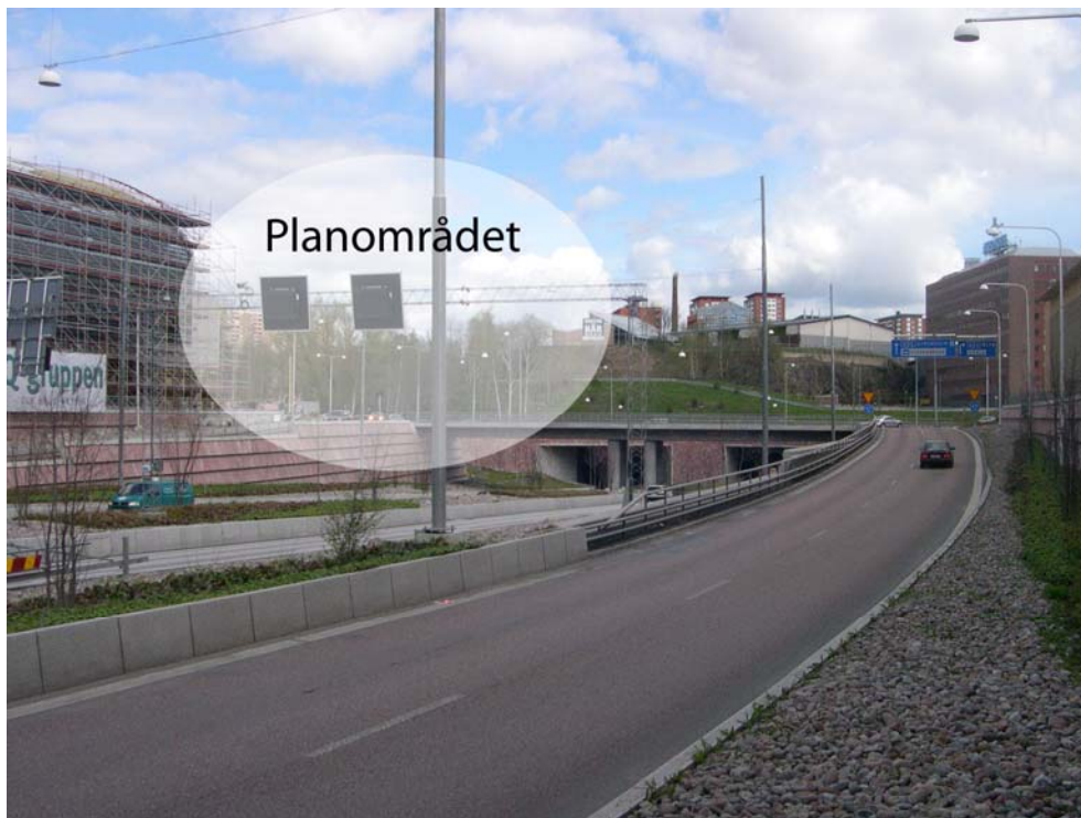
Sicklaön 83:32 sedd från rampen mot Nackarondellen....
