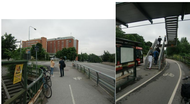
Figur 4. Problempunkt 2 t.v. och problempunkt 4 t.h. (Foto: Sweco)
