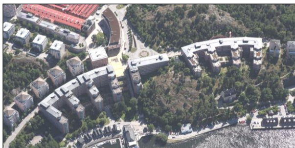
Flygfoto från norr, planområdet omfattar den vänstra av de tre storskaliga byggnaderna i branten.
