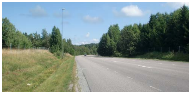
Bred vägbana på Gamla Skärgårdsvägen (väg 622)
