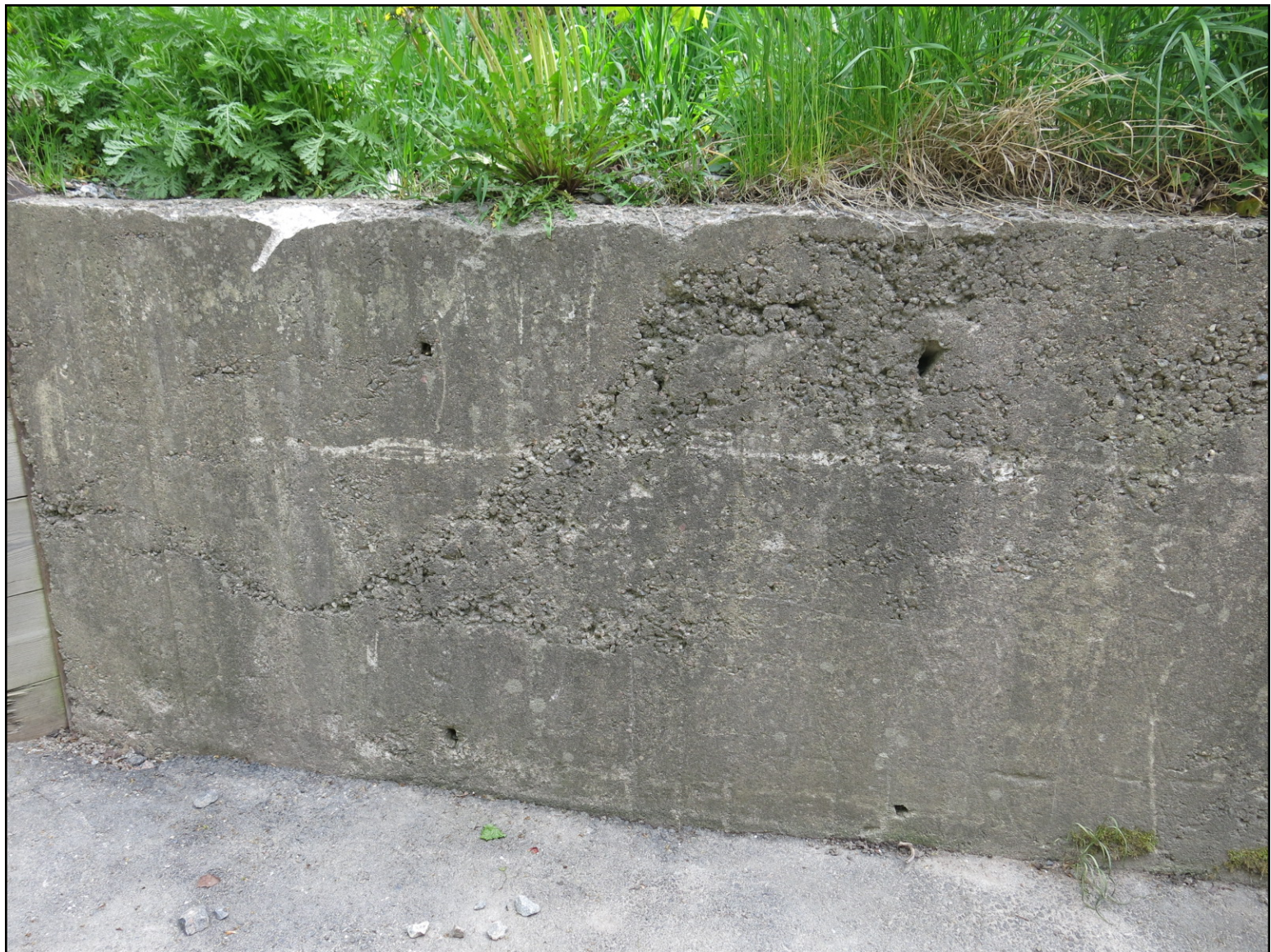
5 - Stödmur - Armerad betong - Gjutsår 2015-05-27
