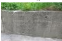
5 - Stödmur - Armerad betong - Gjutsår 2015-05-27
