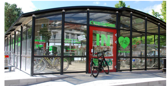
Cykelgarage vid Växjö resecentrum har 62 platser varav 18 är med laddning för elcyklar. Garaget har öppet dygnet runt och kostar 80 kr i månaden att använda 4 .
