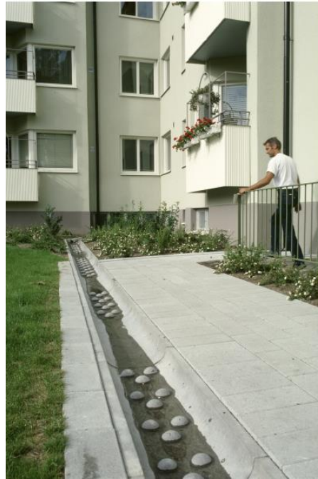
Figur 7.6. Öppet dagvattensystem från stuprör ( www.steriks.se )
