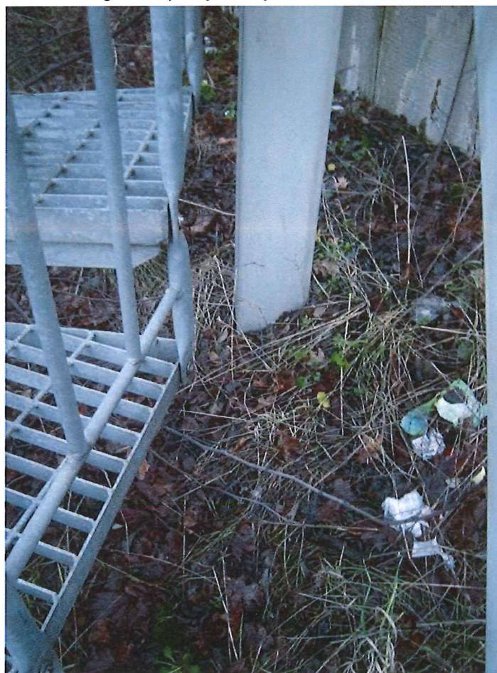
Igenväxt pelarfot och fundament saknas.
