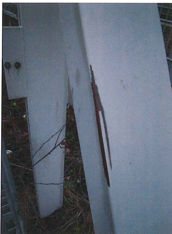
Skador på färgsystemet.
