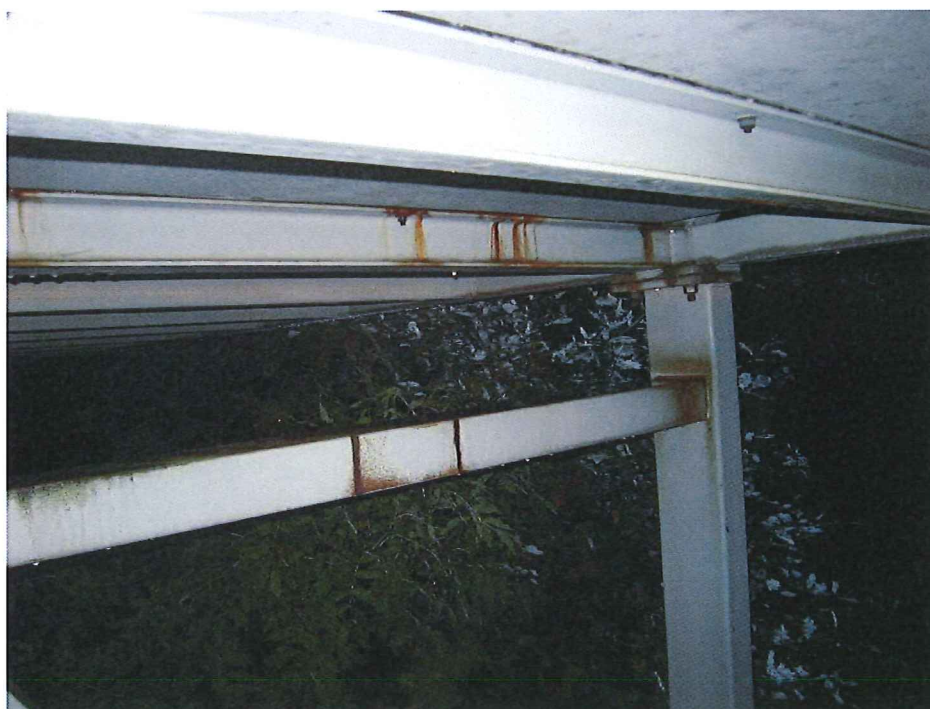
Korrosion på tvärbalk vid mellanstödet.
