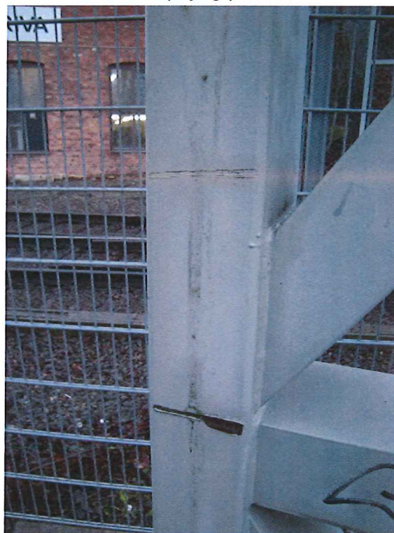
Skador på färgsystemet.
