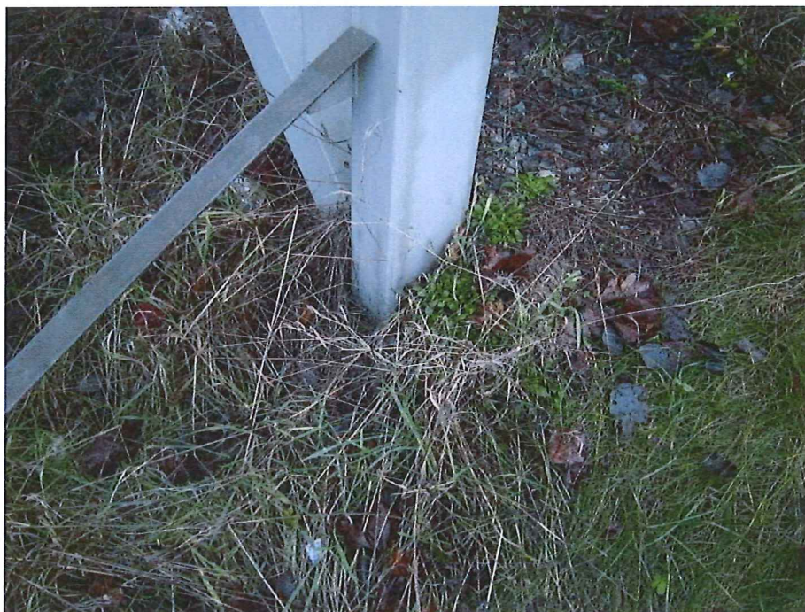
Igenväxt pelarfot och fundament saknas.
