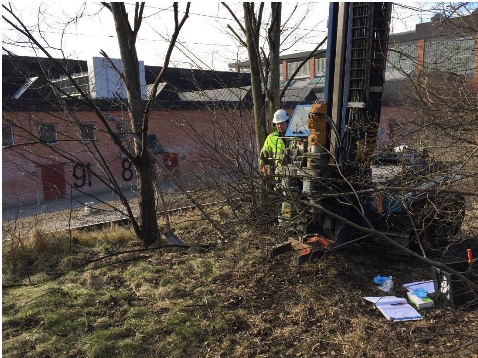
Foto 2. Borring av provpunkt BH2 i grönområdet som ligger i planområdets nordvästra del. Halter av PAH och metaller har påträffats över Naturvårdsverkets riktvärden för KM mellan 0,5-1,0 m.u.my. Borring utfördes ner till 1,9 m.u.my då borrstopp erhöles.
