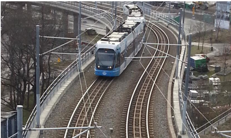
Figur 12. Exempel på brouppbyggnad för spårtrafik inom Trafikförvaltningen. Här ses Tvärbanan mellan Gullmarsplan och Mårtensdal, med skyddsrärl mellan rälsen och en något upphöjd kantbalk i betong.
