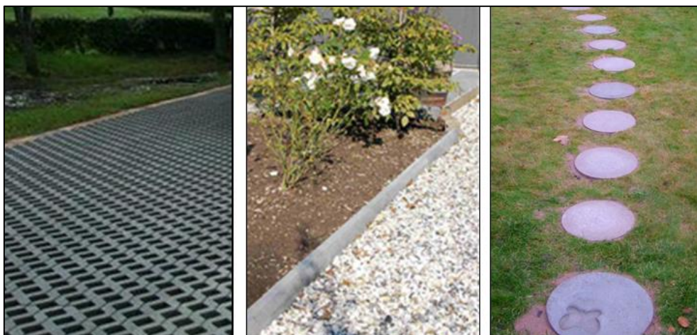
Figur 7. Yta med hålsten av betong, makadambelagd gång, samt gångstig med gräs och ett fåtal gångplattor
