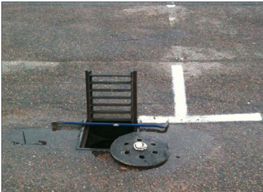
Figur 8. Filterplatta som placeras i rännstensbrunn (Acitex, 2016)
