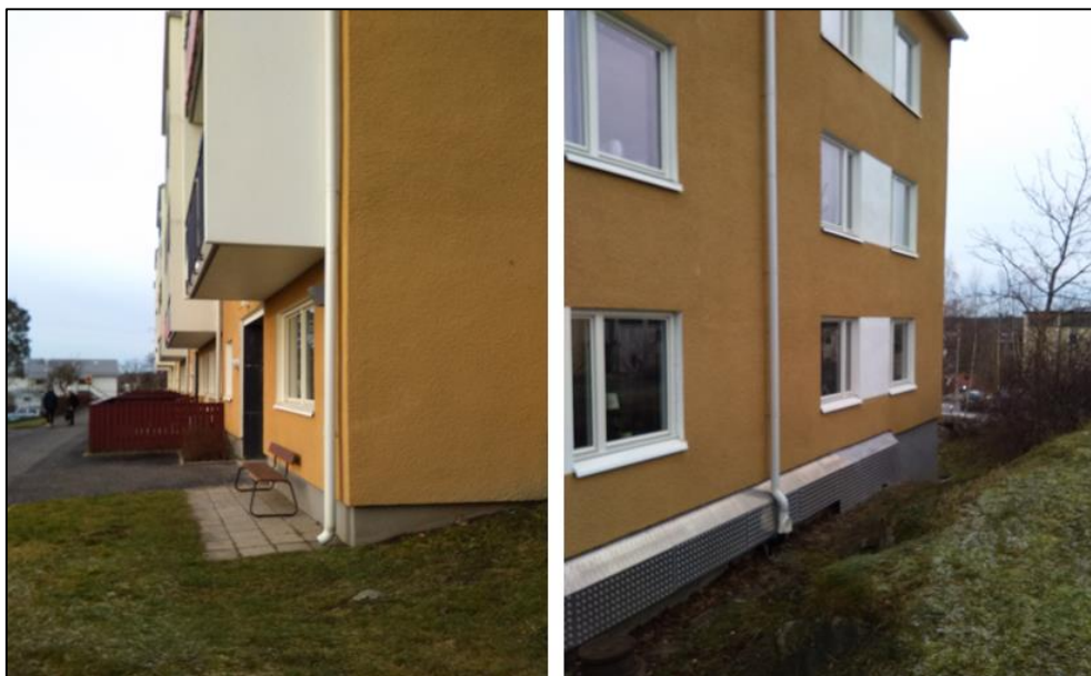
Figur 2. Stuprör med utkastare samt stuprör som leder ner till marken
