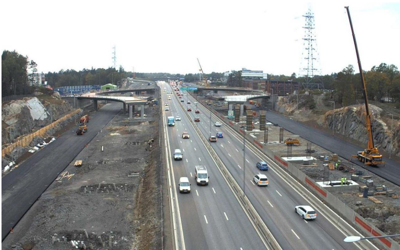
Figur 1. Kungens Kurva, byggskedet av nya körbanor.
