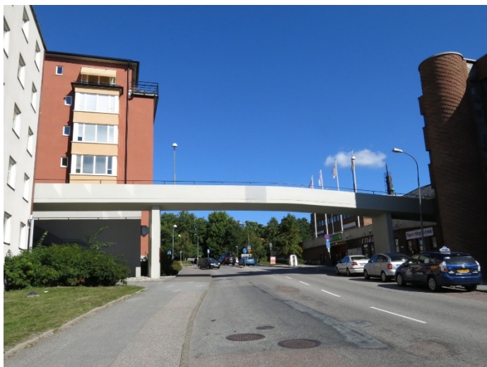
5-Bro över Ektorpsvägen vid Ektorp Centrum GC-väg- IdNr2:S-112
