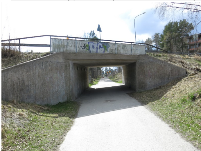
10- Bro över GC-väg på Ornövägen 20m Öst Sandövägen-IdNr2:K-614
