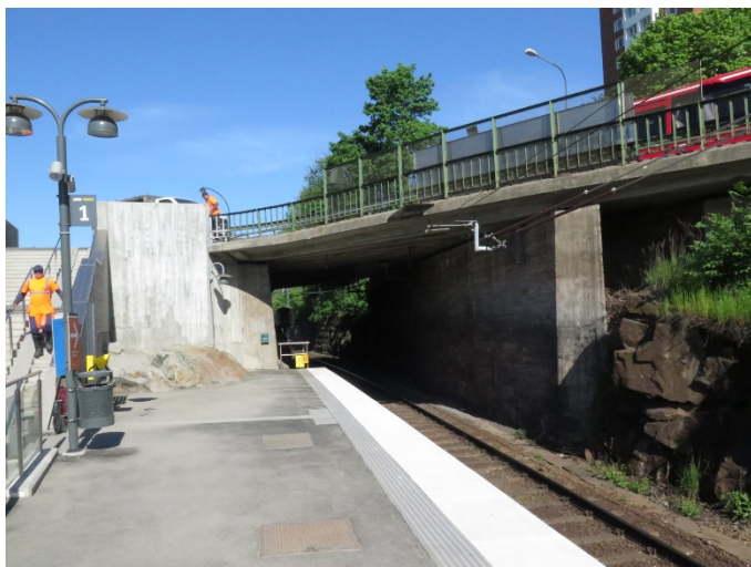
4-Bro över Saltsjöbanan öster Sickla Industriväg på Värmdövägen- IdNr2:S-103
