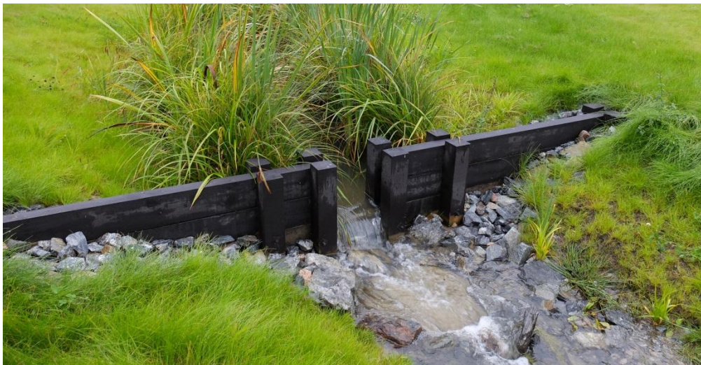
Figur 29. Exempel på dämning av dike med möjlighet att sätta i sättar för att reglera nivån uppströms. Foto Veg Tech AB.
