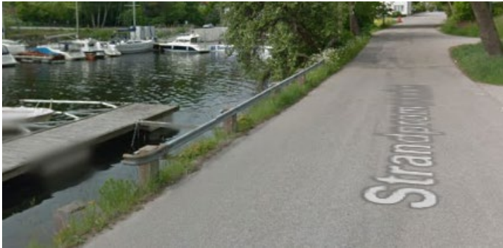
Bild på det räcke som ersattes 2016, stålbalk med betongpelare
