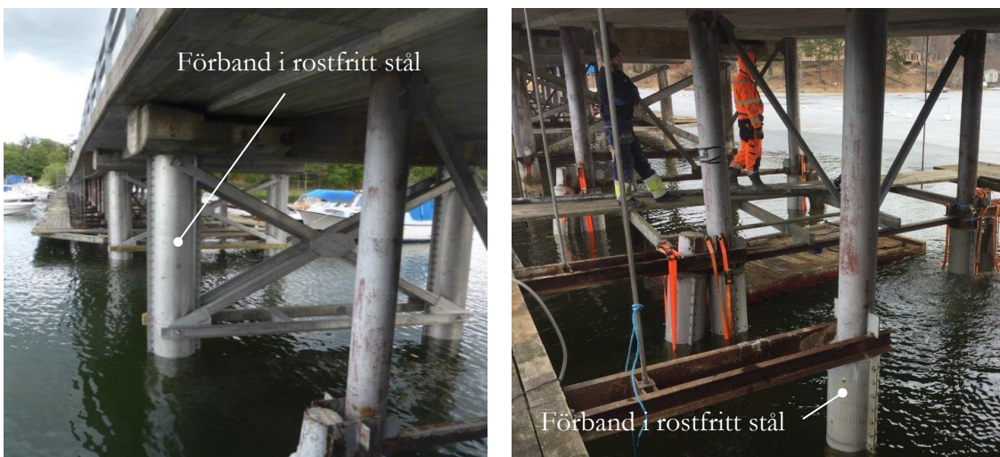
Figur 6: Bilder efter pålreparationer utförda på Tattbybron år 2017.
