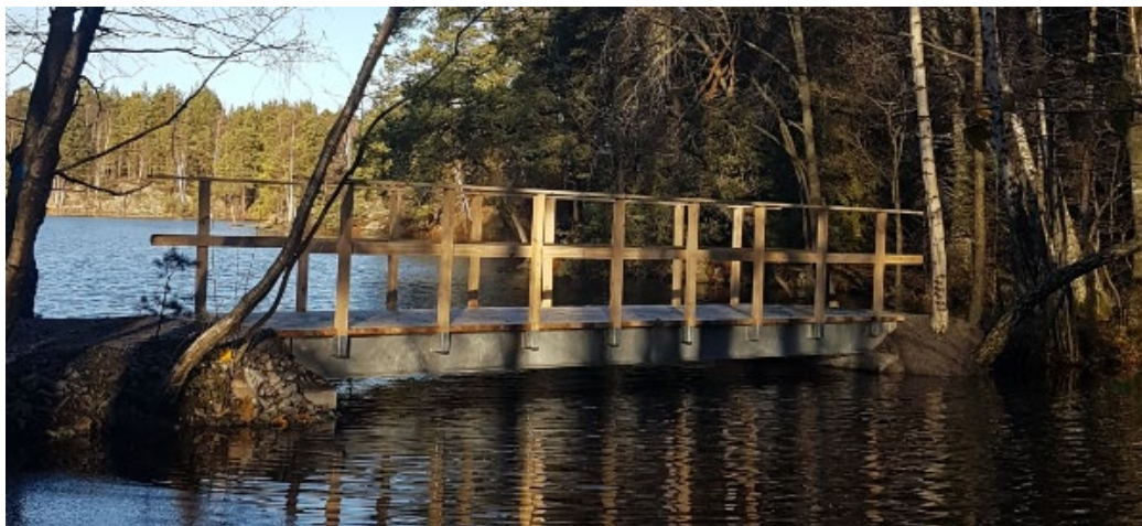
Figur 6: Ny brokonstruktion med fundament (landfästen) på båda sidor.
