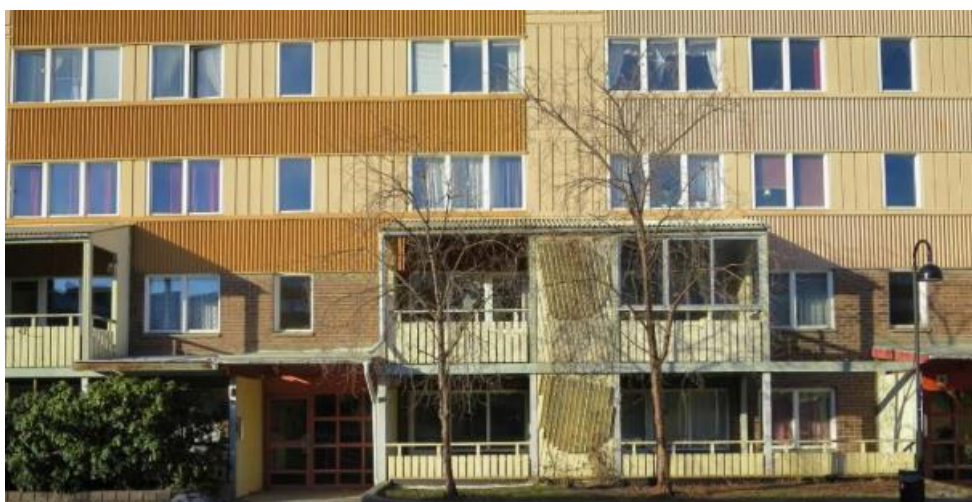
Figur 5. Byggnaderna har en-, två- och treluftsfönster.
