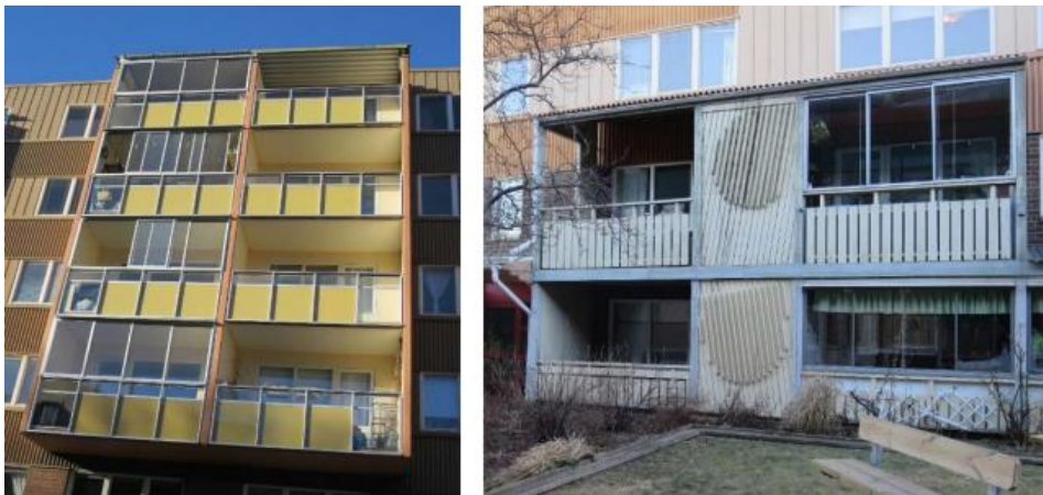
Figur 6. Balkonger samt balkongverandor i trä med konstverk i form av skärmar.
