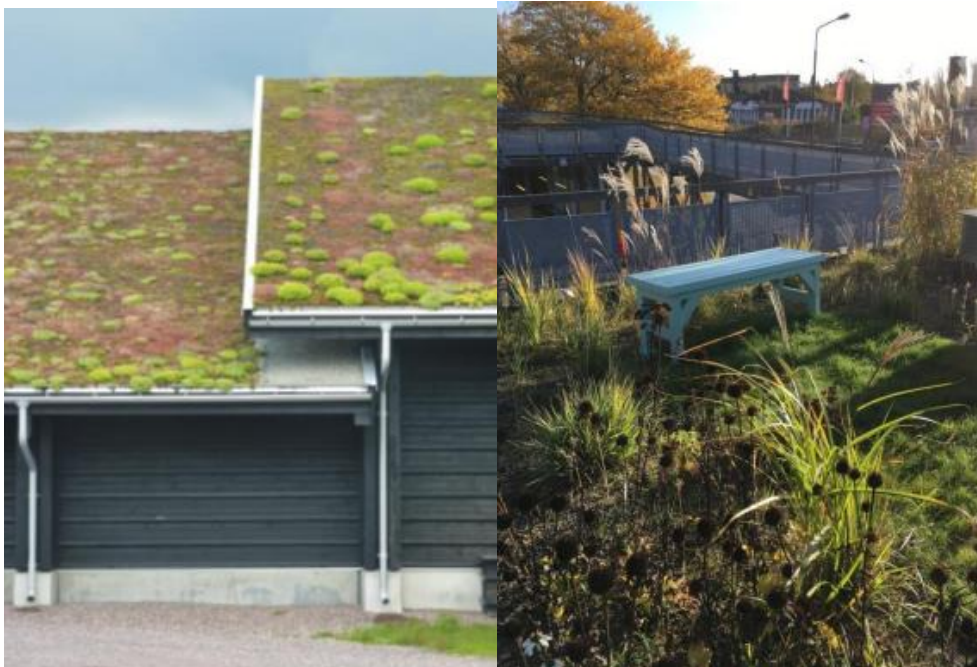
Figur 20. Exempelbilder på tunt grönt tak (till vänster) och tjockt grönt tak (biotak) till höger.
