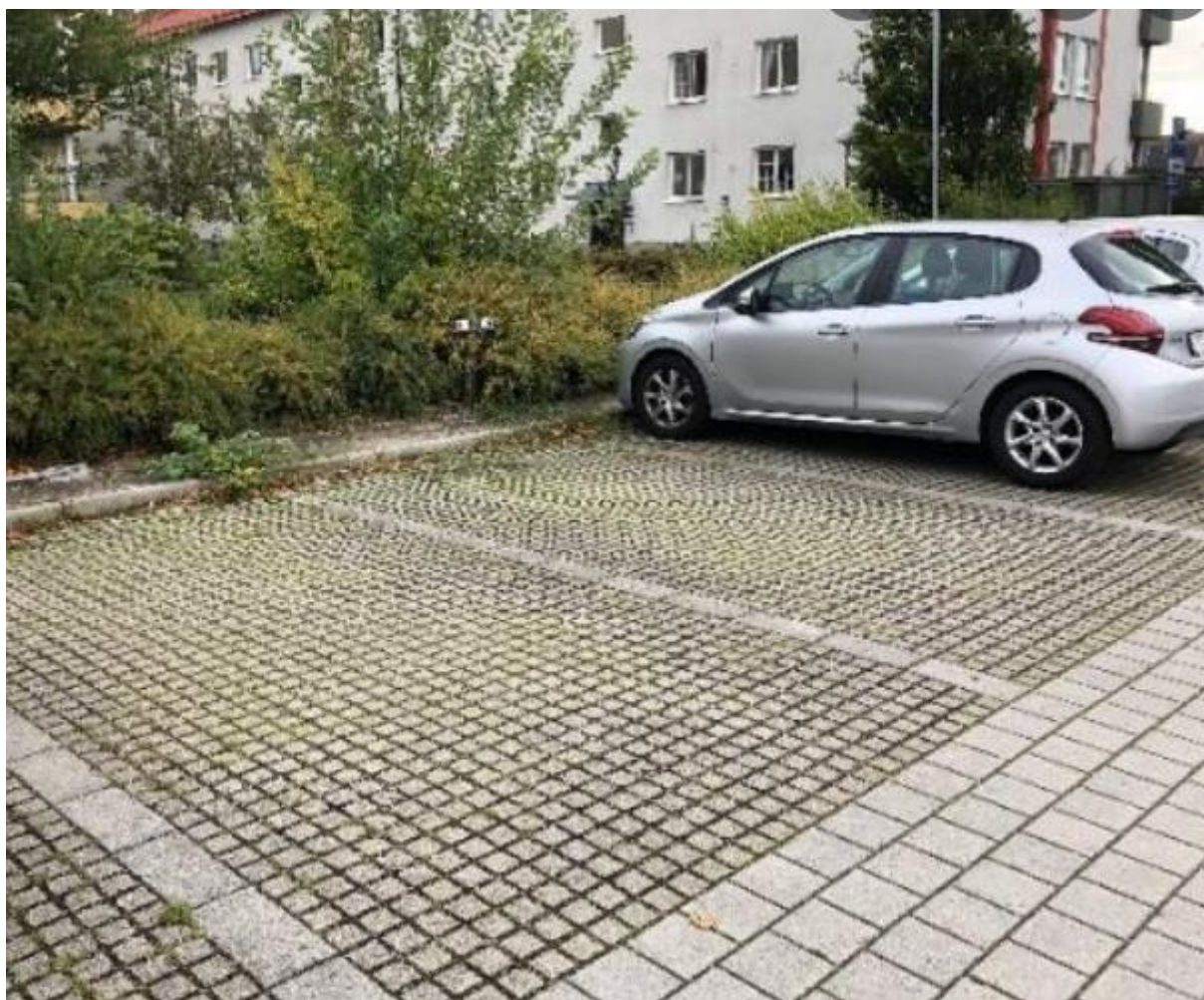
Figur 18. Armerad parkeringsplats för infiltration av dagvatten.
