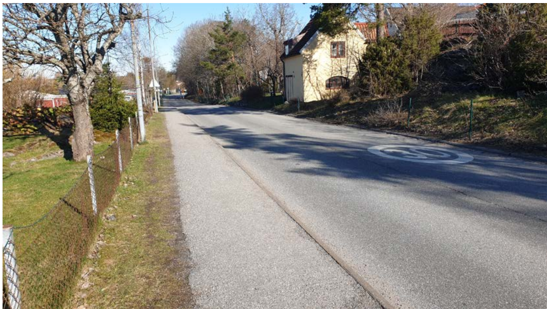
Typisk smal sträcka utmed Evalundsvägen sett norrut med privata fastigheter till höger och arrendefastigheter till vänster. Vägbanebredden understiger 6 meter med varierande gångbanebredd 1,3 till 1,4 meter.
