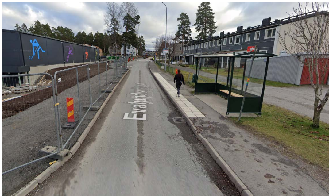
Ny avsmalning s.k. stopphållplats vid Sigfridborgsskolans sporthall sett söderut mot Storkällansväg. Gångbanel bredd framför busskuren understiger 1,4 m och smalnar av till 1,2 m
