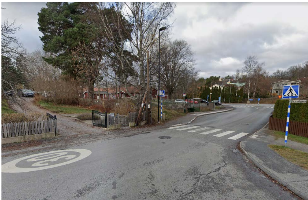
Busshållplats Nyvägen sett norrut med Erstaviksvägen i bakgrunden som korsar Evalundsvägen i en minirondell. Hållplatsen har en plattformsbredd på 1,8 meter som kan anses vara normalt med gångbanebredd på 2,0–2,2 meter
