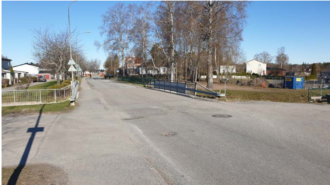
Konstbyggnad i form av gångtunnel som starkt begränsar gatuutrymmet. Vägbanebredden är runt 6,5 meter medan gångbanebredden hamnar endast på ca: 1,2 meter
