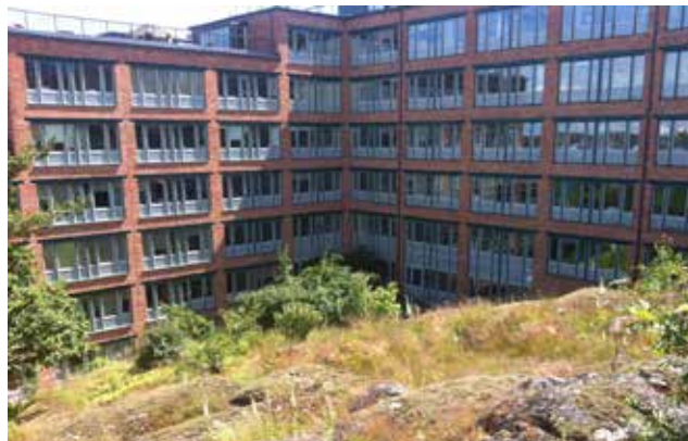
Befintlig byggnad från sjösidan
