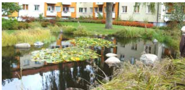
Exempel på en dagvattendamm i en bostadsmiljö
