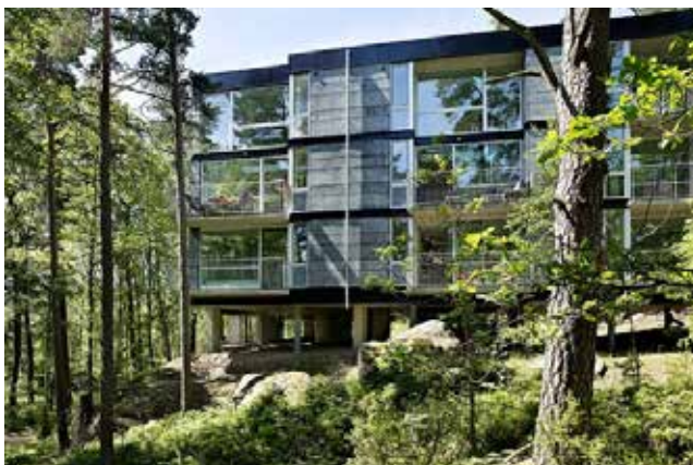
Referensbild på hus som tillåter naturen att fortsätta under husen, HSB Hassmycket i Lerum.
