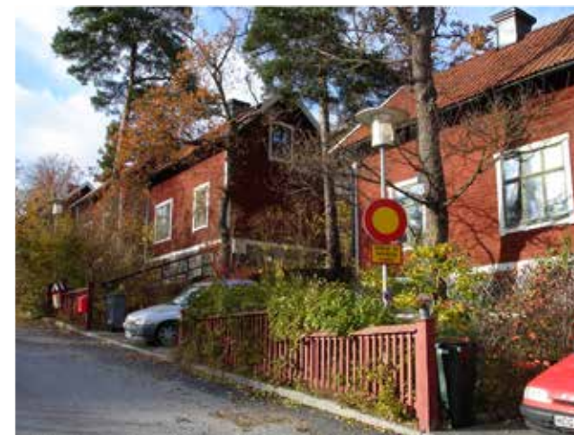
Tändkulevägen med före detta arbetarbostäder från 1908-1910 är ett viktigt industrihistorisk uttryck. Miljön kompletterar bilden av Augustendals äldre historia. I kommande planläggning bör skyddet ses över, samt hur nya hus ska förhållas till trähusbebyggelsen.
