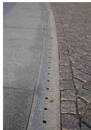
Exempel på dagvattenränna för ytlig avledning
