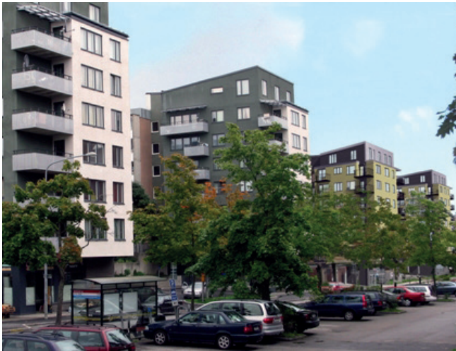
Exempel på förtätning genom påbyggnader på befintliga hus i Tensta allé. Bild: Svenska bostäder och Bergkrantz arkitekter.
