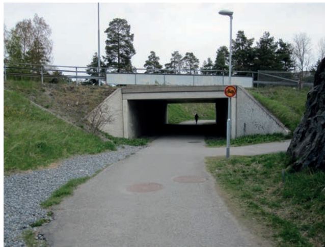
Gångtunnel mellan Fisksätra och Erstavik
