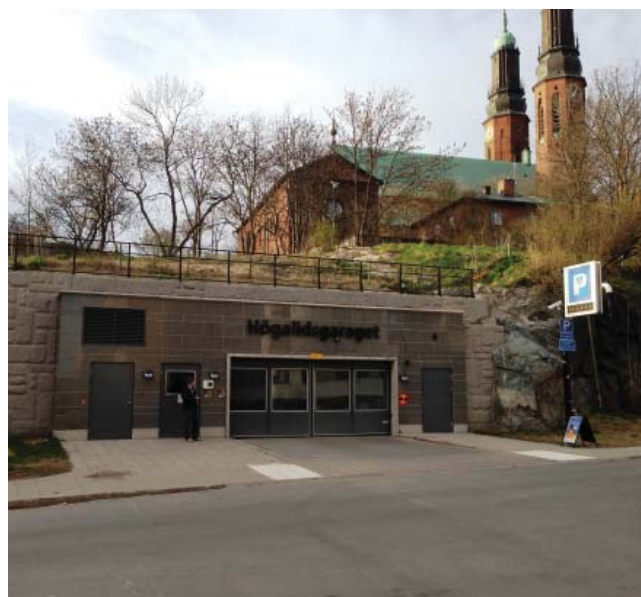
Högalidsgaraget - exempel på bergrumsgarage
