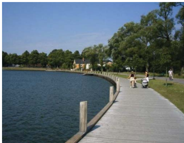
Exempel på strandpromenad med dagvattenrening i Växjö. Sedimenteringen sker under bryggan genom att orenat vatten skiljs från renat vatten med hjälp av en avskärmande duk under vattentamm (bildkälla: Sweco).
