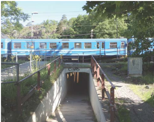
Tunnelundergången under Saltsjöbanan idag. I detta läge är förlängningen av Planlavägen är tänkta att gå.
