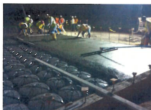
Figur 10b. Betong påförs över Cupolex®-formerna och armeringsjärnen.
