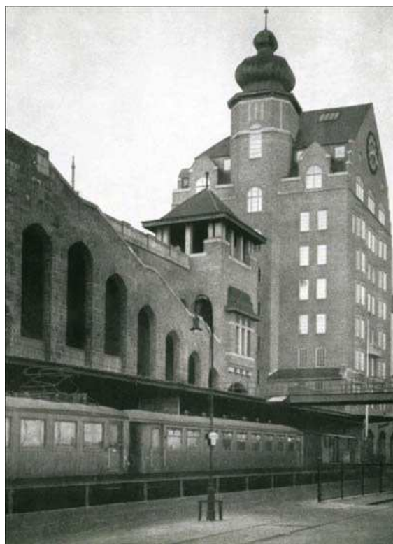
Fig 3,4. På den övre bilden ses murarnas och vilplanets spetsbågiga valv. Smidesräcken i jugendstil. Den nedre bilden visar byggnaden i början av 1900-talet då den fortfarande fungerade som slutstation för Saltsjöbanan. Trappan och murarnas karakteristiska spetsbågiga valv syns tydligt. Bild: Stockholms stadsmuseum (överst) respektive okänd (ovan).
