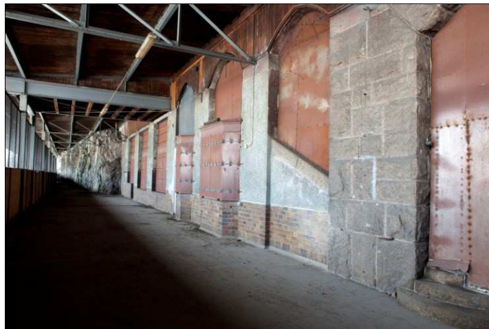
Fig 5. På bilden ovan ses perrongen med igensatta biljettluckor. Murarna är spritputsade, klädda med hårdbränt fasadtegel eller i natursten.
