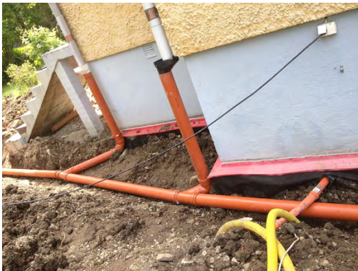
Bild 4. Dagvattenledningarna från stuprören till kassetten i gräsmattan
