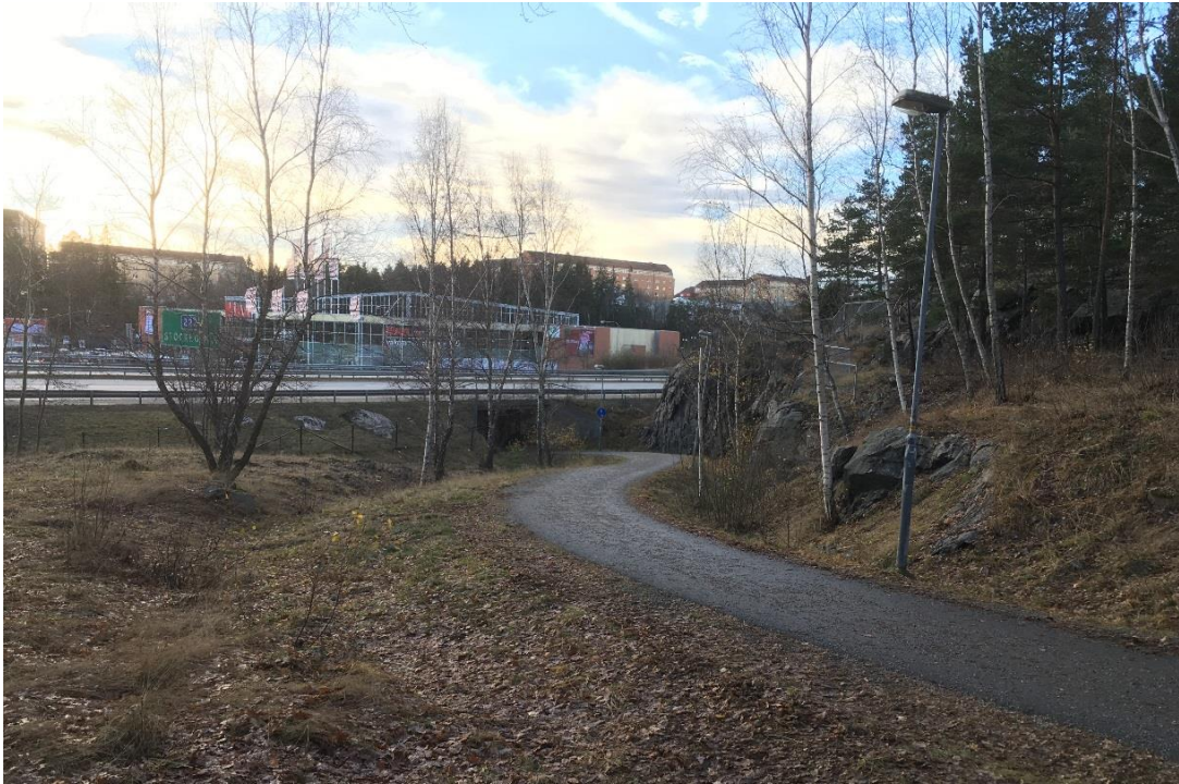
Figur 33. Gång- och cykeltunnel under Värmdöleden.
