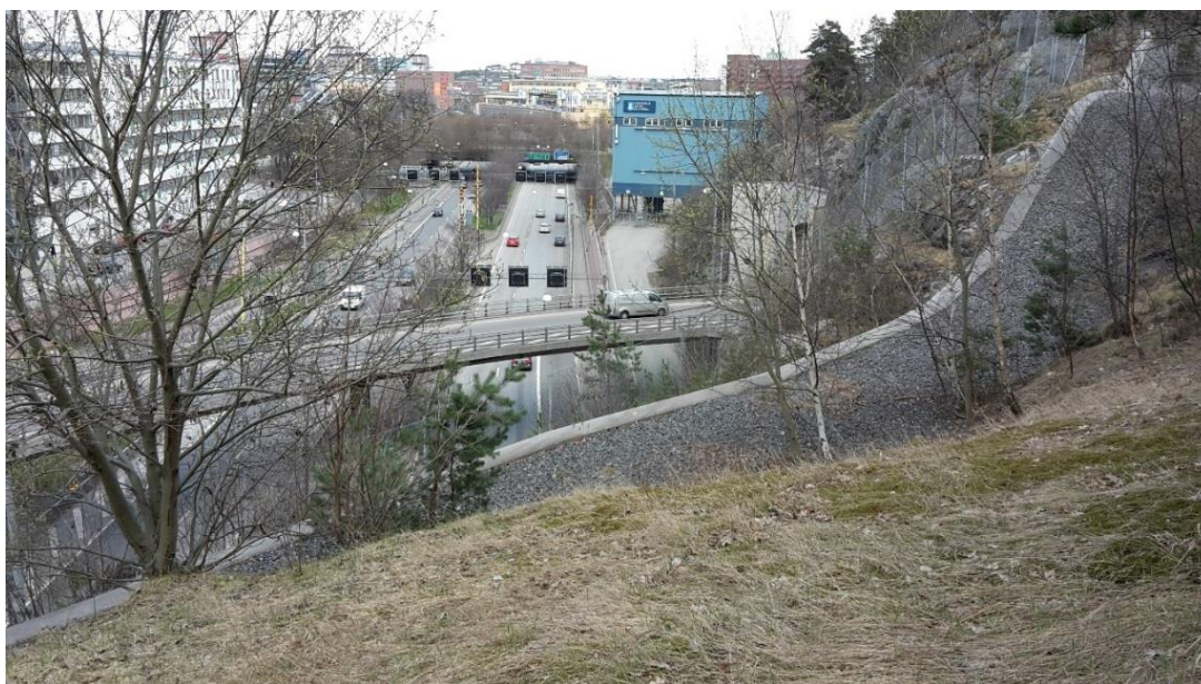
Figur 30. Tunnelmynning av Södra länken.
