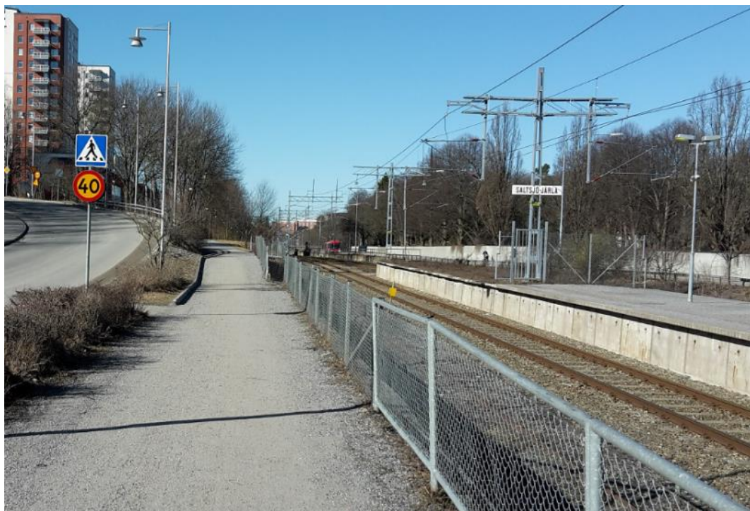
Figur 29. Passage under järnvägen vid station Saltsjö-Järsla, ledningsdragningen fortsätter sedan längs med gång- och cykelbanan.
