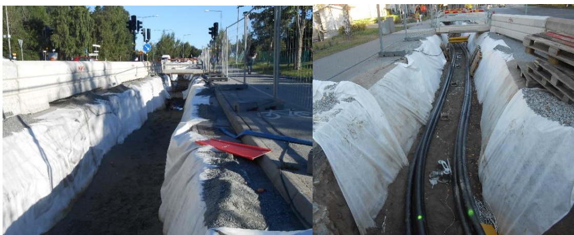
Figur 6. Exempel på markkabelschakt i stadsmiljö.
