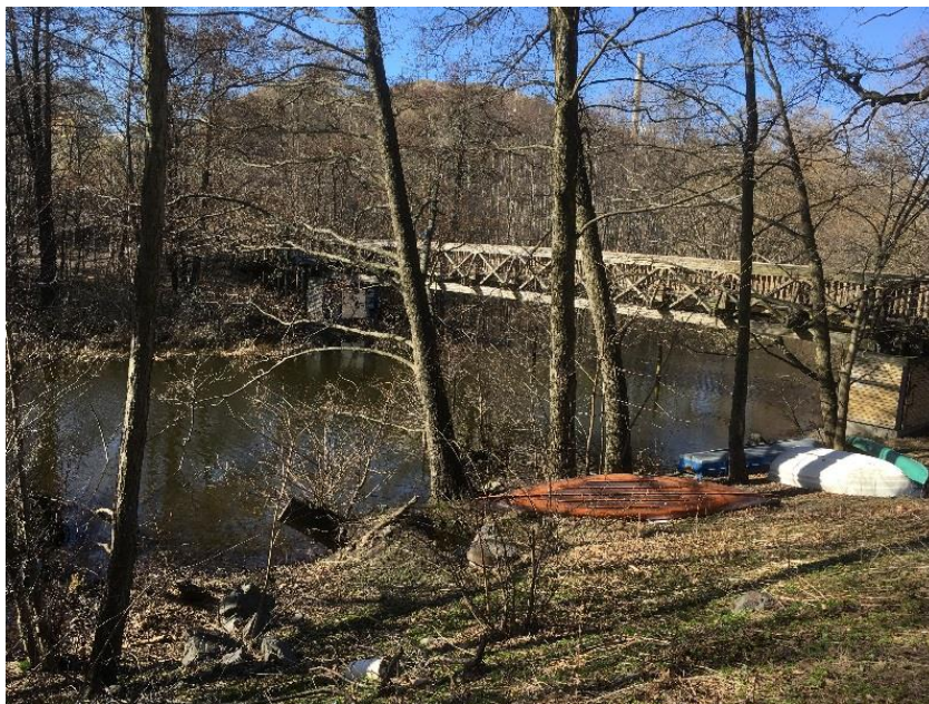
Figur 20. Gång- och cykelbro över Sicklasjön.
