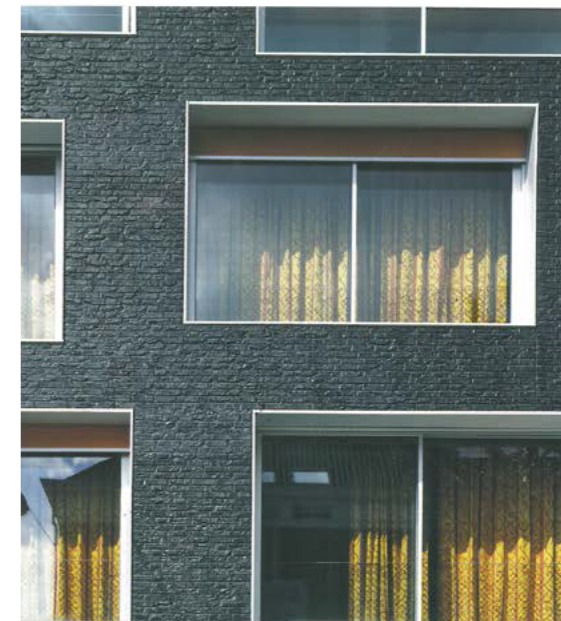
Bra exempel på hål i mur med detaljerad fönsternisch Studentboende (Claus en Kaan Architecten)
