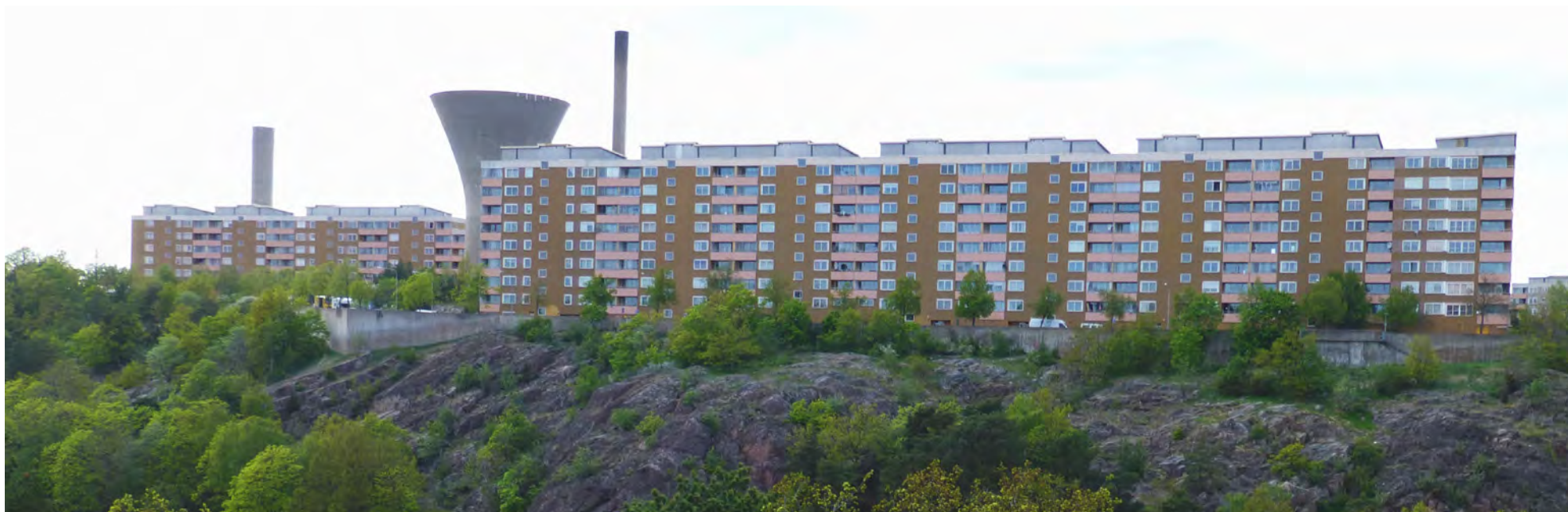
Bebyggelsen på Henriksdalsberget. Skorstenen och vattentornet utgör landmärken synliga från långt håll, vy från söder
