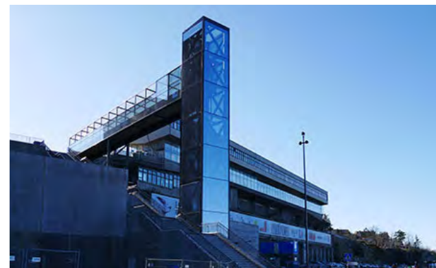
Referensbild, hiss som exempel på förbindelse mellan olika marknivåer
