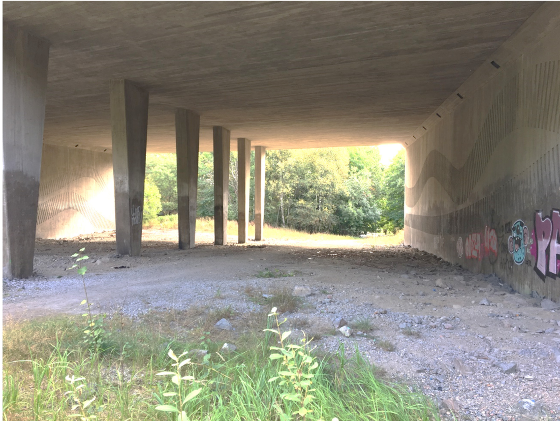
Vägporten i Birkavägens förlängning sedd från Ryssbergen.
