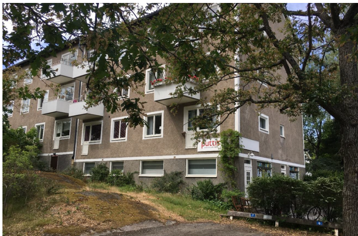
Figur 5. Flerbostadshuset på fastigheten Björknäs 1:239 byggt 1949. Notera fasaddetaljerna i vit slätputs. Foto: Viktor Wallström
