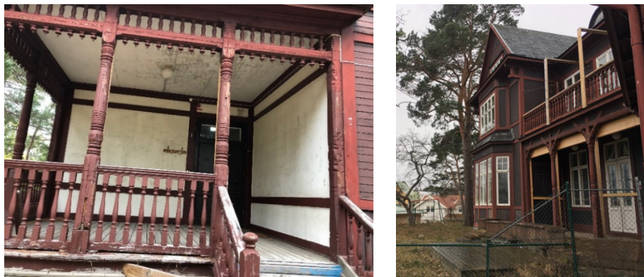
Villorna låg högt på stengrunder utan bekväm markkontakt. Verandor, balkonger och altaner gav kontakt med omgivande natur. Vänster foto: Eva Sundström, höger foto: Viktor Wallström
