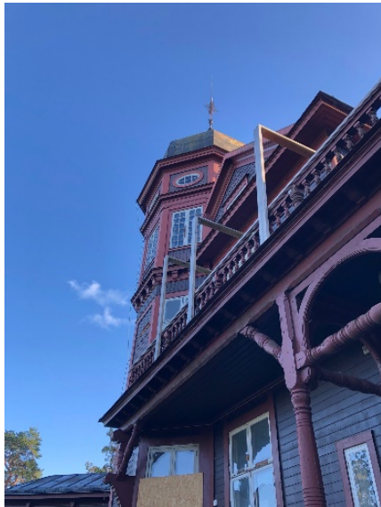
Villa Gadelius torn med lökkupol klädd med plåttak. Foto: Eva Sundström
