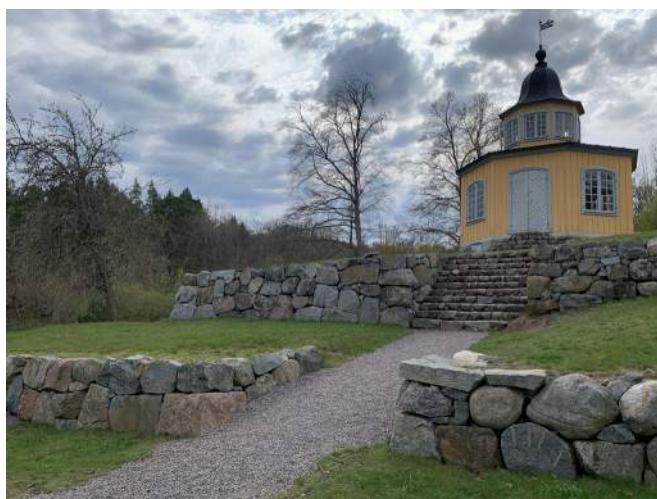
Stenmurar i terrasser och stentrappan till lusthuset.
