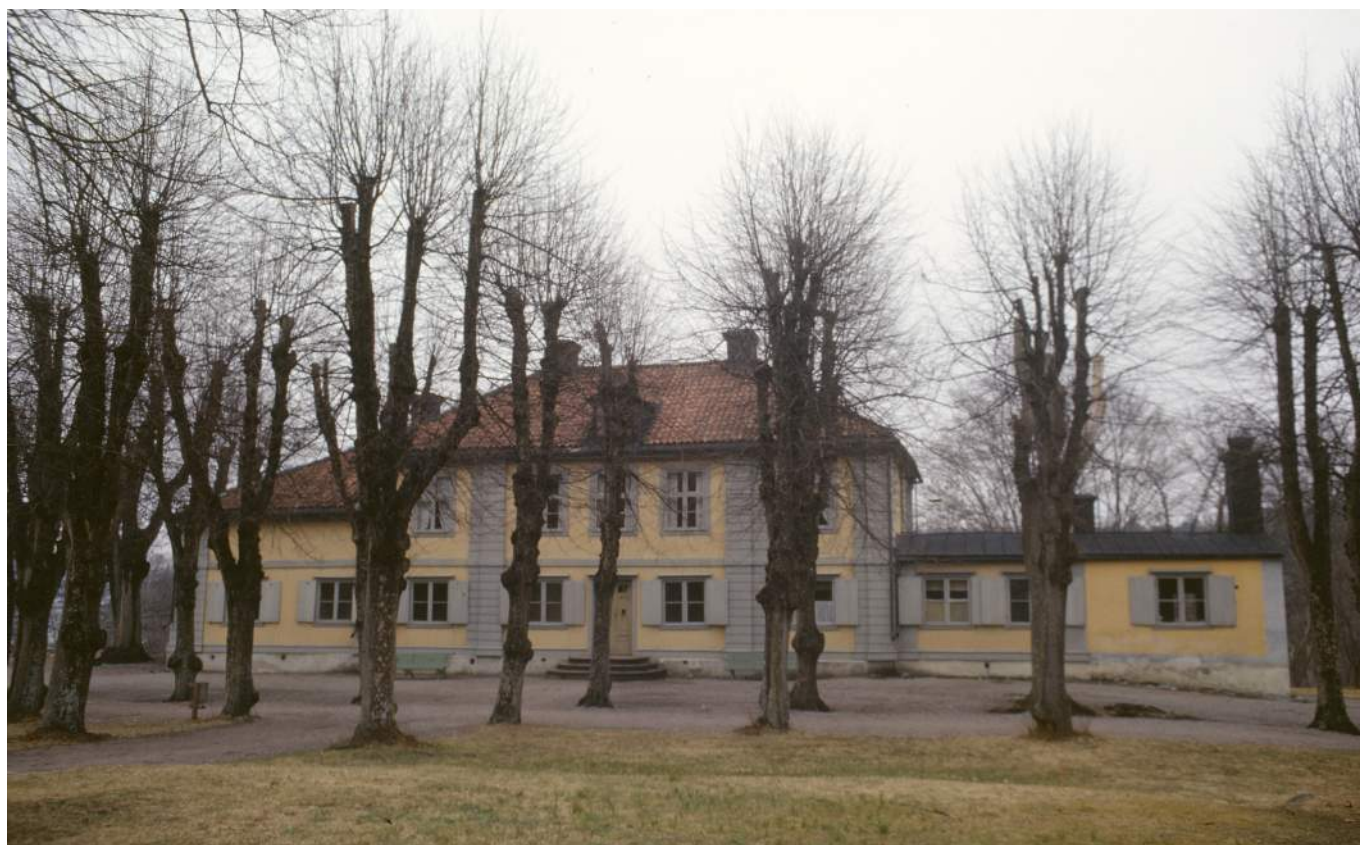
Huvudbyggnadens västra fasad, år 1963. Foto: Alf Nordström.
