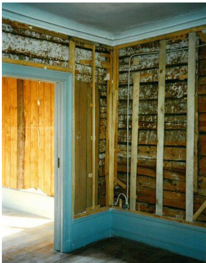
När de 30 år gamla gipsskivorna togs bort för att ersättas av tunnare skivor blev äldre väggbeklädnader synliga. Foto: Eva Göransson, 1996.
