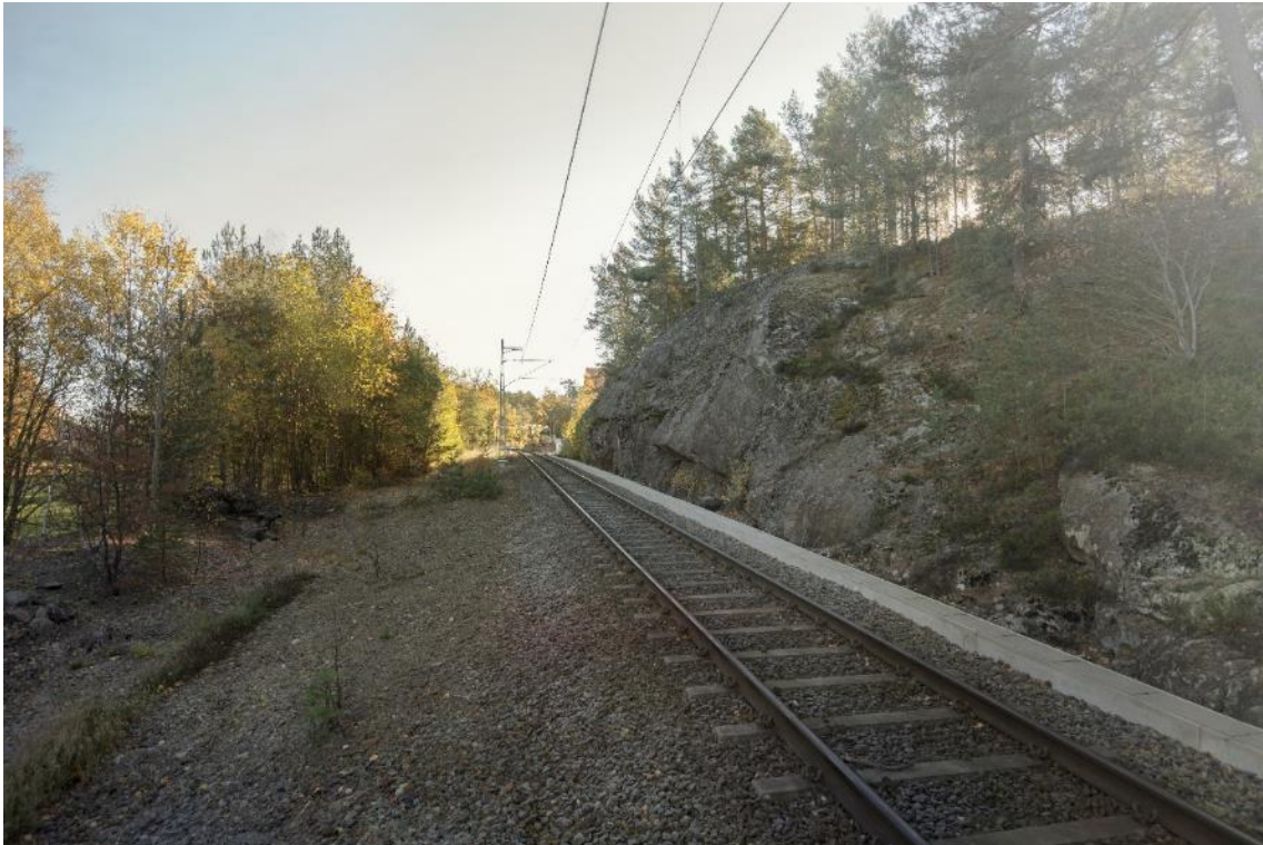
Dagens enkelspår, vy från väster. Till vänster ses befintlig slänt av krossmaterial. Till höger ses nuvarande bergskärning. Foto av Sweco.
