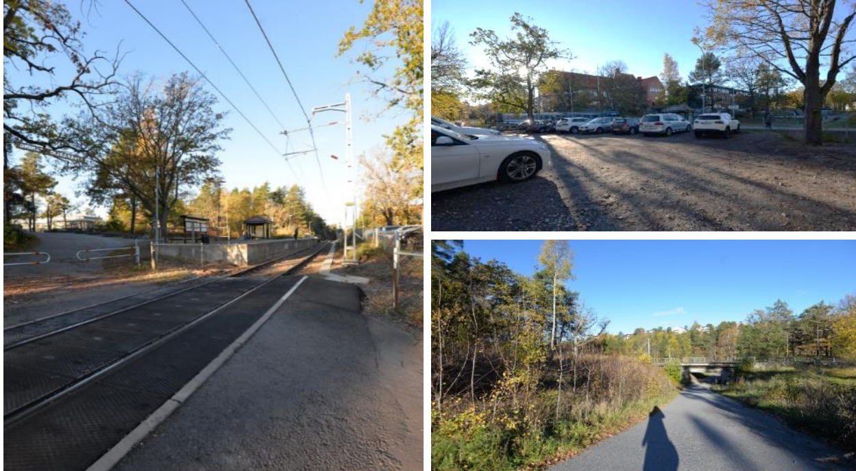
Till vänster ses befintlig plattform. Till höger ses parkering och gång- och cykeltunnel (sett från söder). Foton av Sweco.
