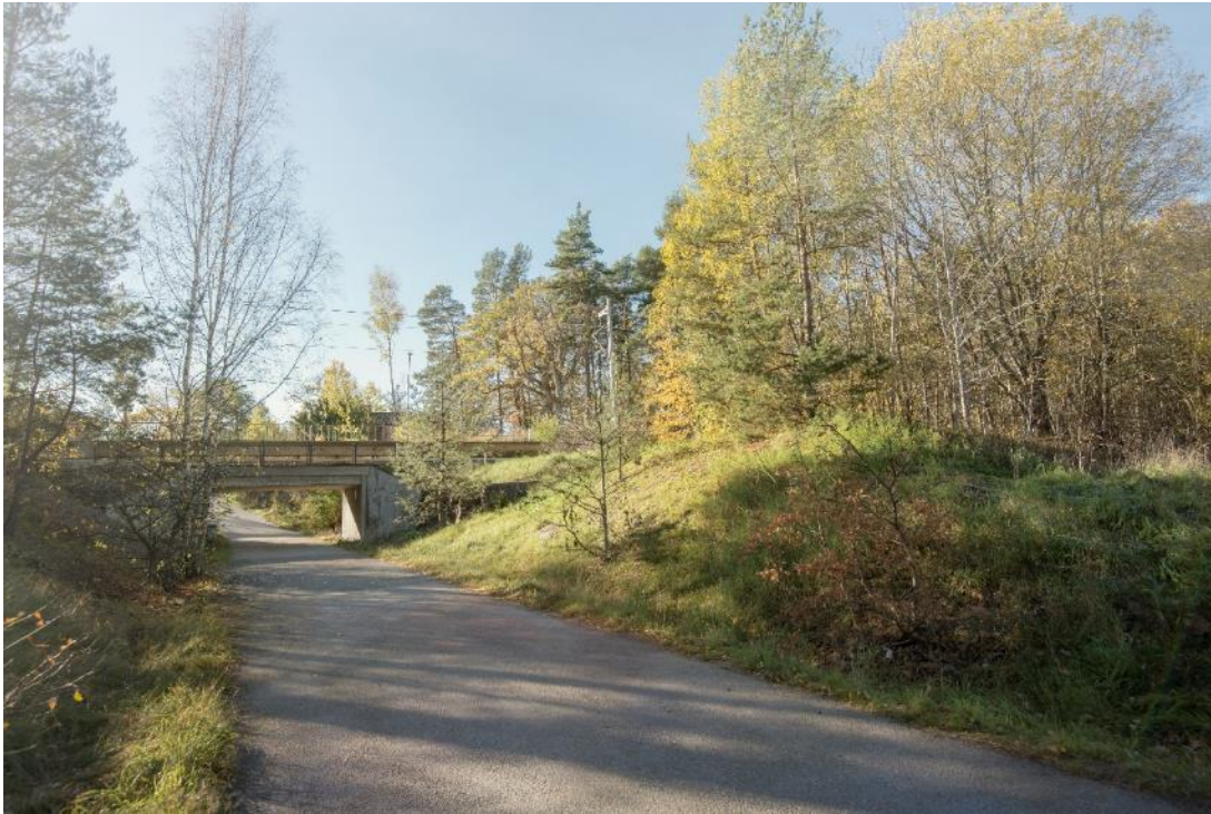
Dagens gång- och cykeltunneln som kopplar samman områden norr och söder om Saltsjöbanan, vy från norr. Foto av Sweco.
