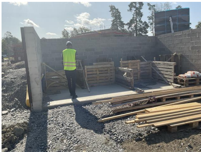
Bild 1. Foto från arbetsplatsbesök den 28 augusti 2024. Platta och väggar påbörjade.
