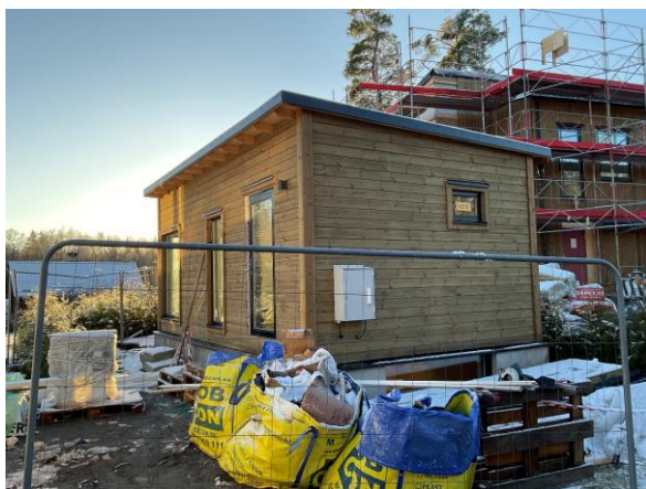
Bild 1. Fotot från slutsamråd 3 december 2024 visar uppförd byggnad.
