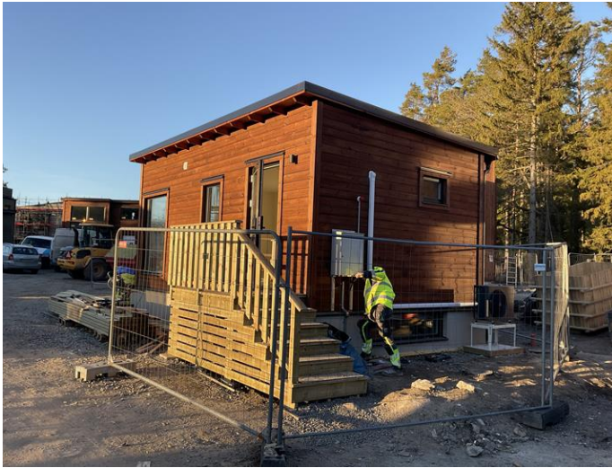
Bild 2. Foto från slutsamråd 17 december 2024 visar uppförd byggnad.
