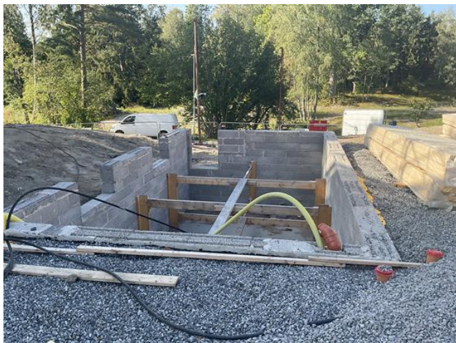
Bild 1. Foto från arbetsplatsbesök den 28 augusti 2024. Platta och källarväggar påbörjade.
