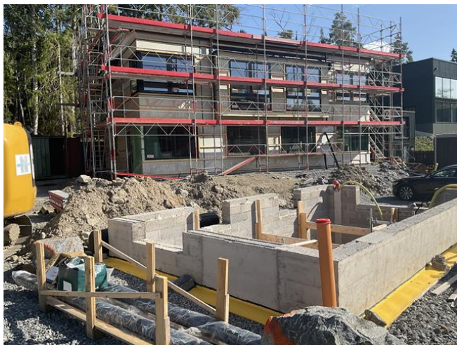
Bild 1. Foto från arbetsplatsbesök den 28 augusti 2024. Platta och källarväggar gjutna.
