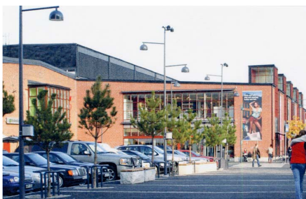
Sickla galleria rymmer byggnaderna 313, 314, 322
