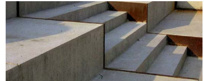
Platsgjuten betongtrappa med kantstöd av corténplåt
