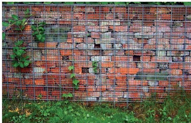
Gabion som tegelmur
