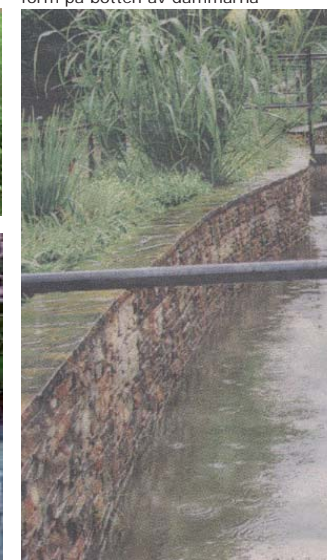
Tegel från bruket kan användas som stödmur mot vattenytan eller i krossad form på botten av dammarna
