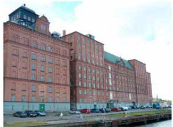
Hus 03-09 från nordost.
