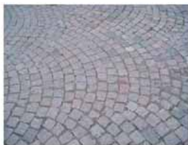
Exempel: Smågatsten i befintligt bågmönster.
