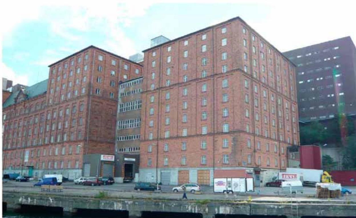
Hus 11 sett från norr.
