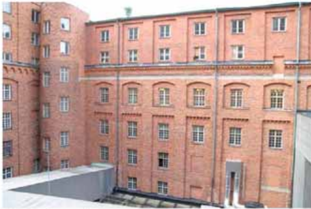
Hus 06 från söder.
