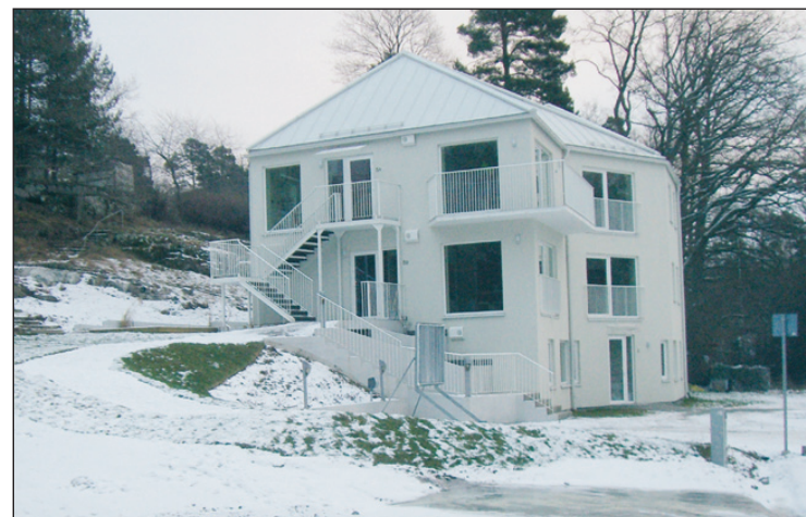
Ett år senare är huset på plats och marken runt om återställd.
