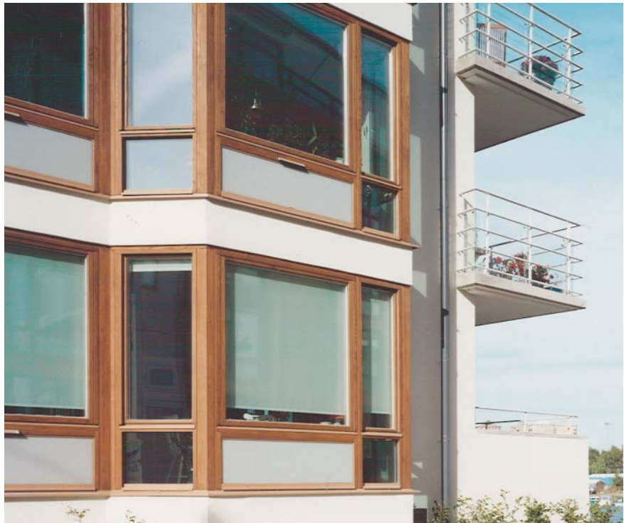
Ekfärgade snickerier samt balkong med glas och stålräcken, Sickla udde.
