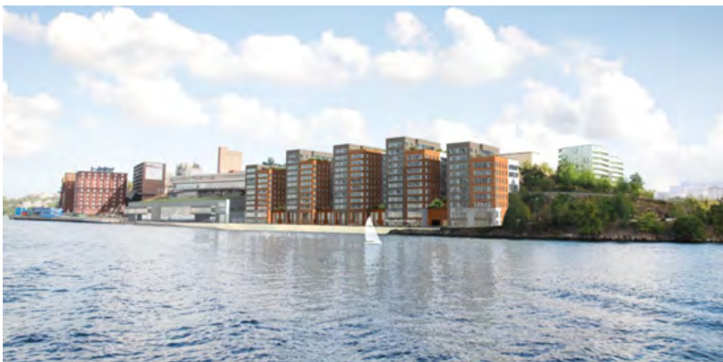
Norrhusen, nordvästra kajen, vy mot sydost
