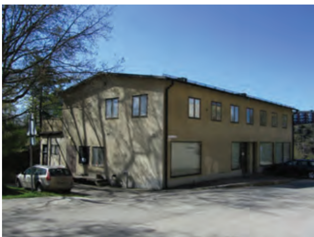
Butikshusets ursprungliga användningsområden kan avläsas med butiksfönster på bottenvåningen och bostadsfönster på övervåningen.
