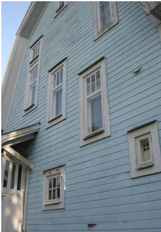
Husets baksida mot norr med trappvis placerade trapphusfönster.
