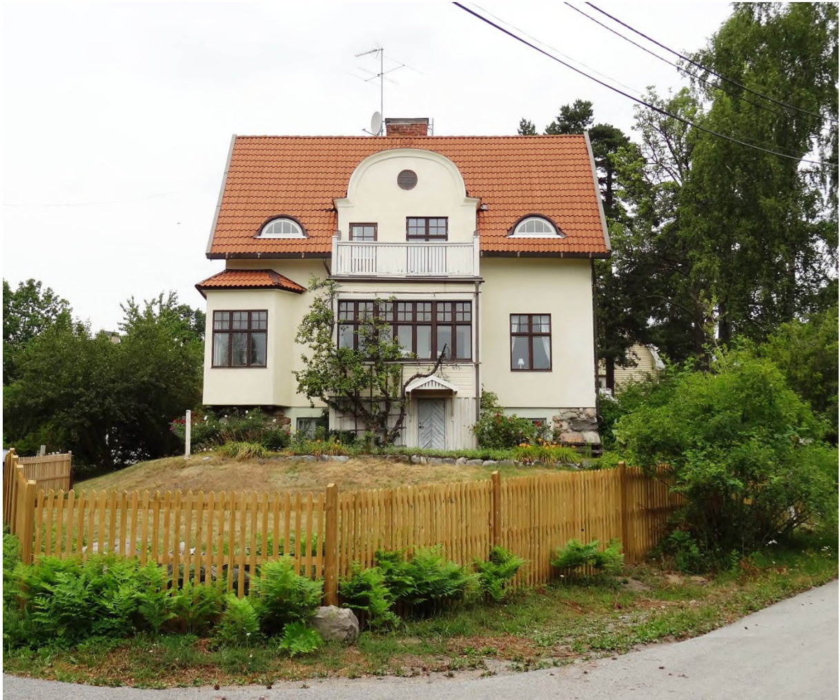
Igelboda 20:6 sett från hörnet Sagavägen/Odenvägen.
