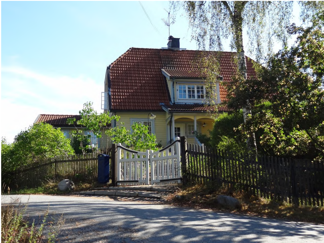
Igelboda 23:19, huvudfasaden sedd från Norevägen.
