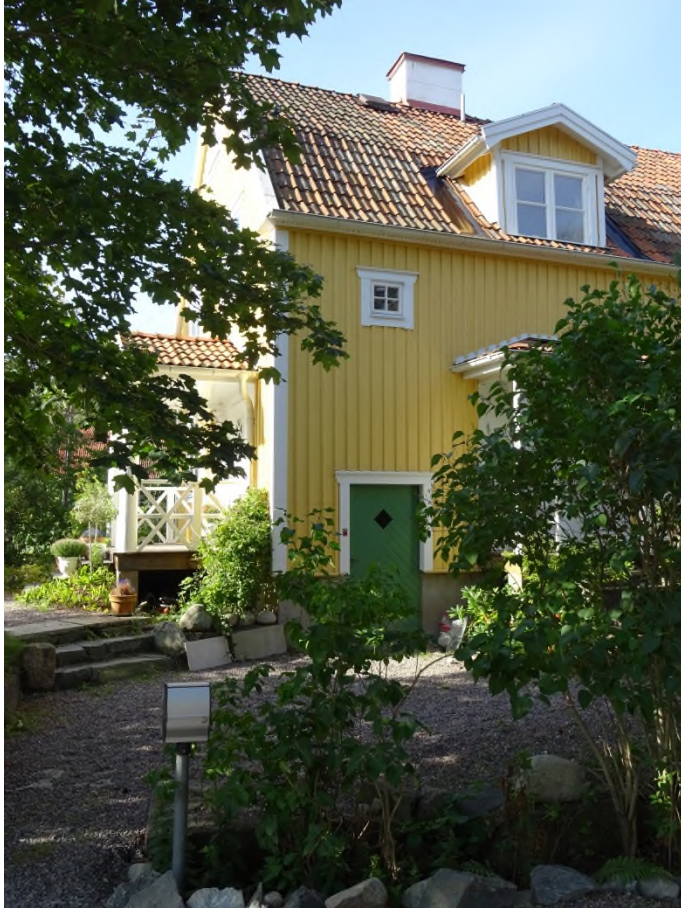
Igelboda 19:1, byggnadens ursprungliga del sedd från Irisvägen.
