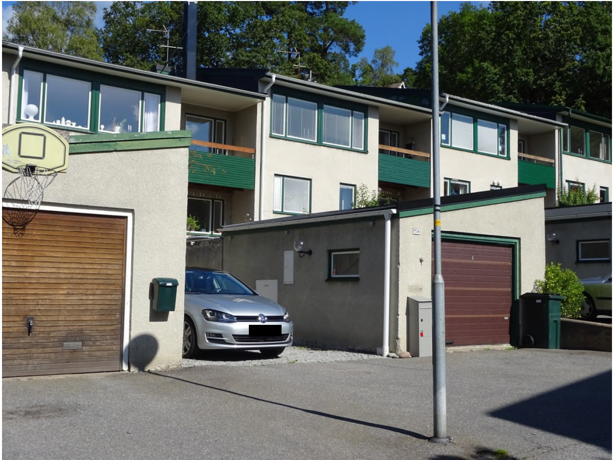
Igelboda 37:19-23 sett från Valhallavägen.
