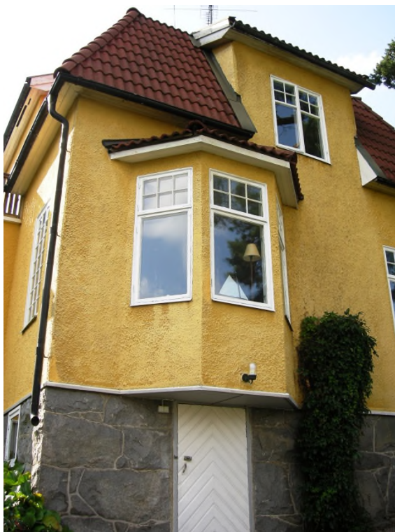
Detalj av fasaden med burspråket.
