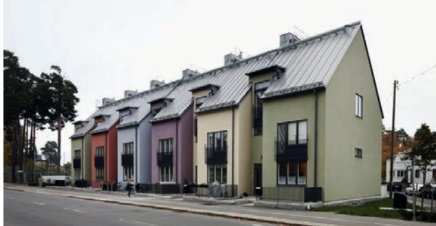
Radhus i Kärrtorp, Stockholm. Årets Stockholmsbyggnad 2012. Fotograf: Per Kristiansen, Arkitekt: Andersson Arfwedson.
