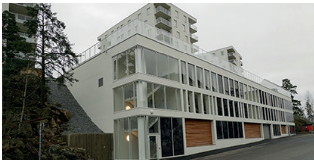
Parkeringsgarage i brant terräng utmed Oxelvägen i Älta. Arkitekt: Sjögren arkitekter AB.
