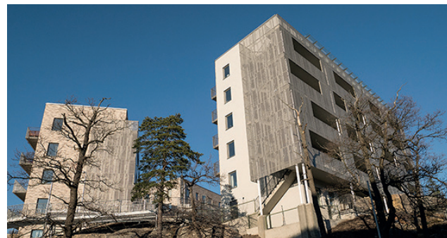
Lokomobilvägen, Nacka strand. Flerbostadshus i svår terräng. Arkitekt: Semrén & Månsson AB.
