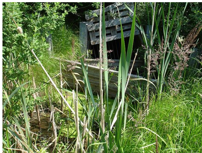
Gammalt dämme vid kulvert vid utfart till Nacka Trä.
