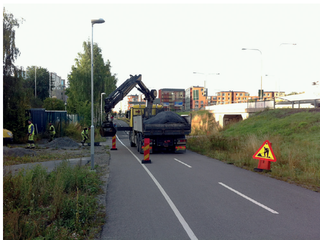
Vägarbete på gång- och cykelväg vid Sicklavägen.
